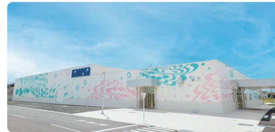
新設した苫東工場
