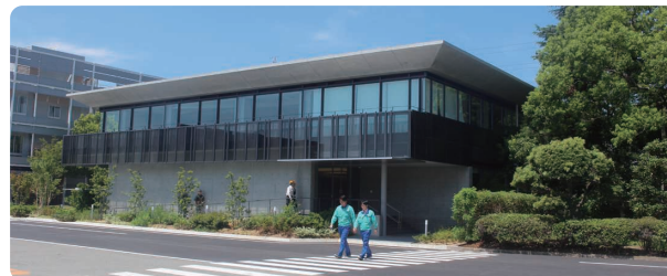
当社有機EL照明や太陽光発電を活用した新事務所棟
