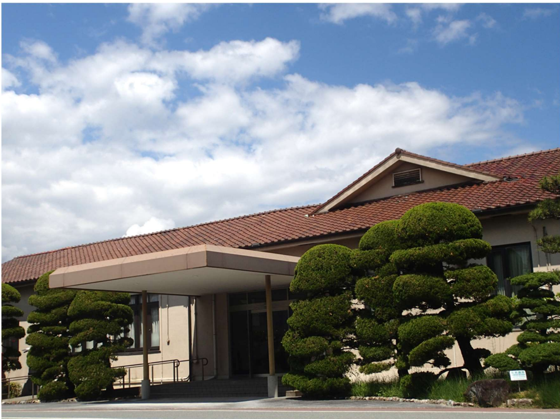
株式会社カネカ 高砂工業所 事務所建屋（1955年建設）
