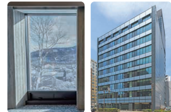
ガラス一体型発電システム 「T-Green® Multi Solar」の設置例 (左: シースルタイプ、右: カラータイプ)
