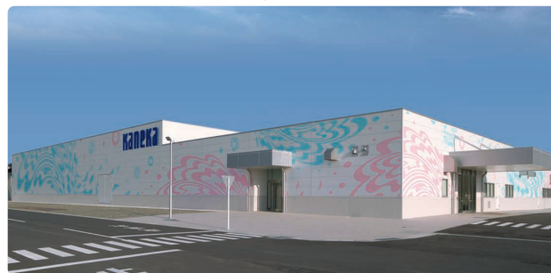
本格稼働を控える苫東工場
